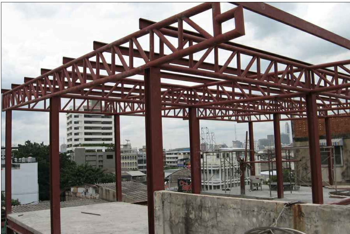
งานโครงสร้างลิฟท์และ โครงหลังคา
