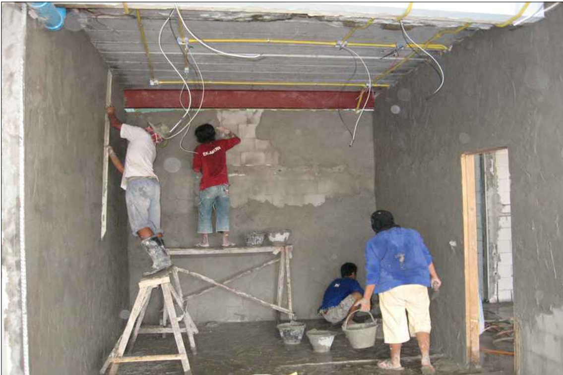
งานก่ออิฐและ งานฉาบปูน
