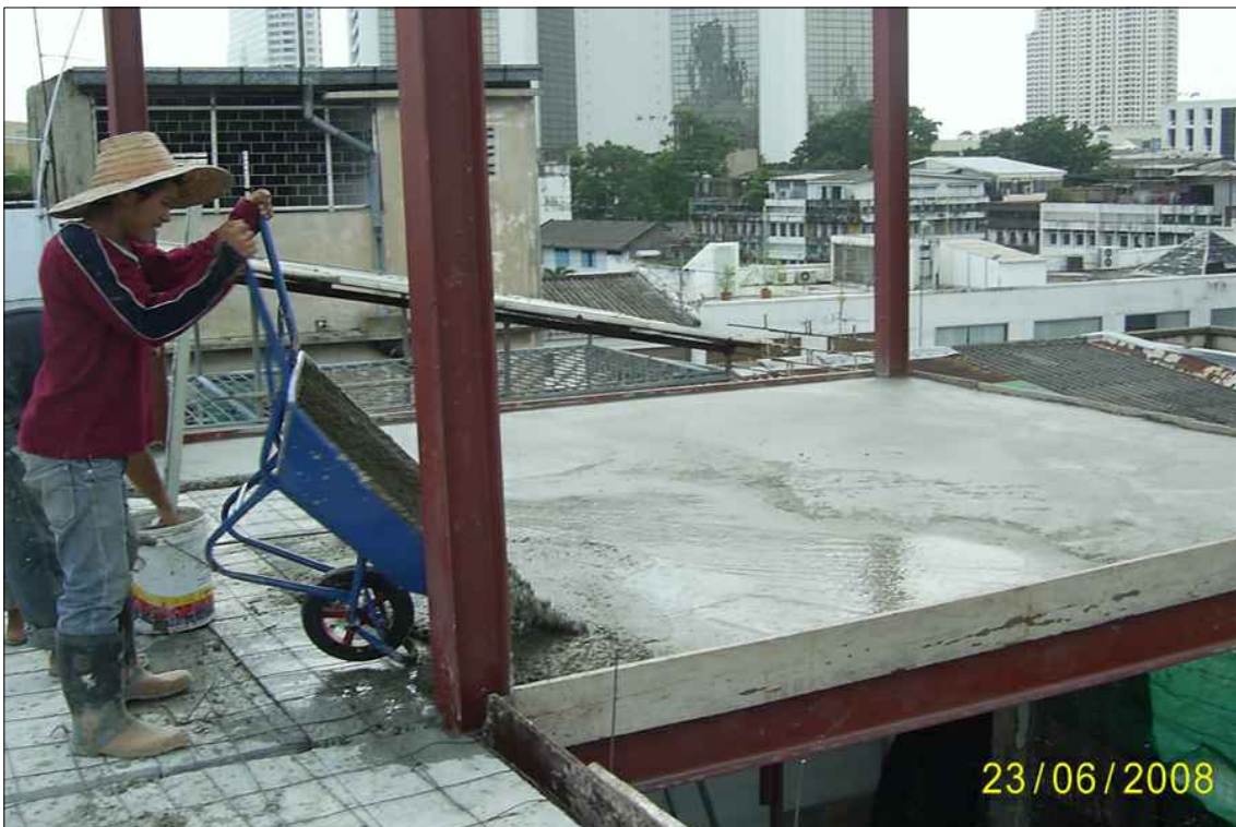
งาน โครงสร้างพื้นคอนกรีตเสริมเหล็ก
