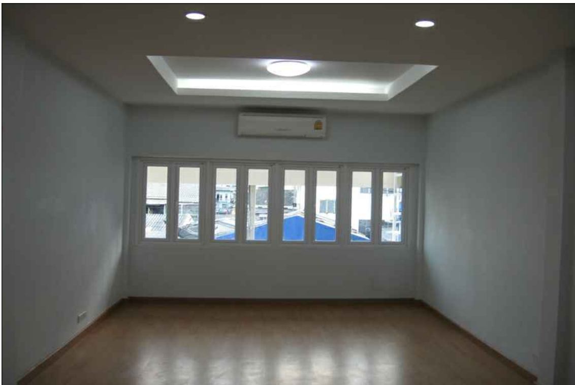
ห้องน้ำและ ห้องนอน หลังปรับปรุงเสร็จ
