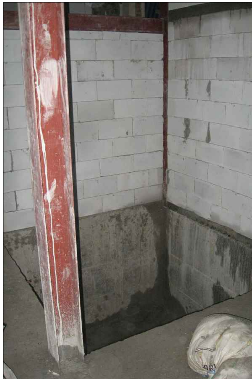
งานเสาเข็มและ งานฐานราก
