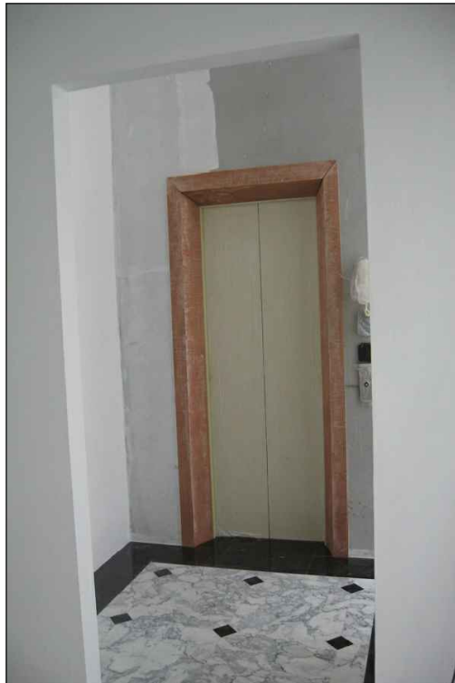
งานตกแต่งโครงหลังคาและ ลิฟท์
