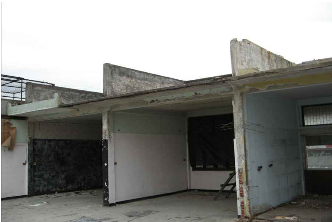
งานสำรวจสถานที่ ก่อนปรับปรุง
