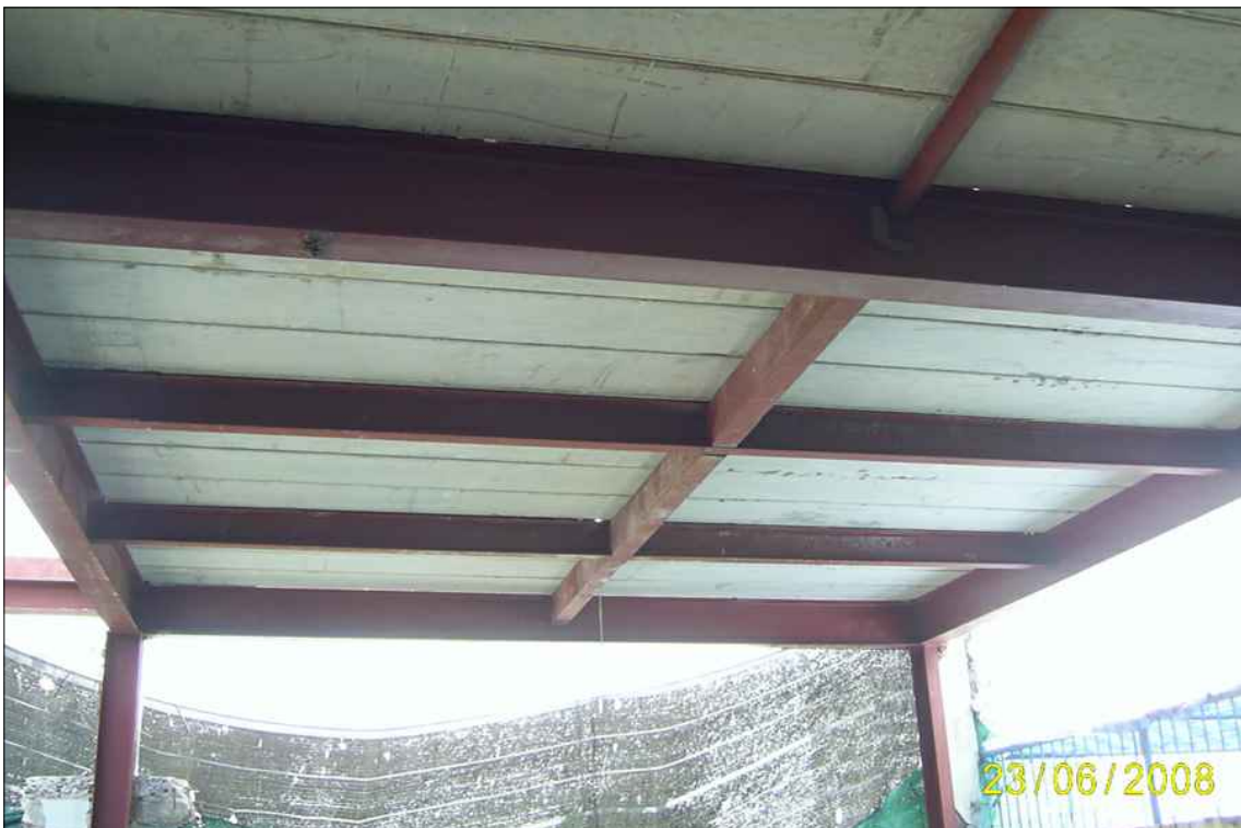
งานโครงสร้างคานเหล็กและ โครงสร้างหลังคา
